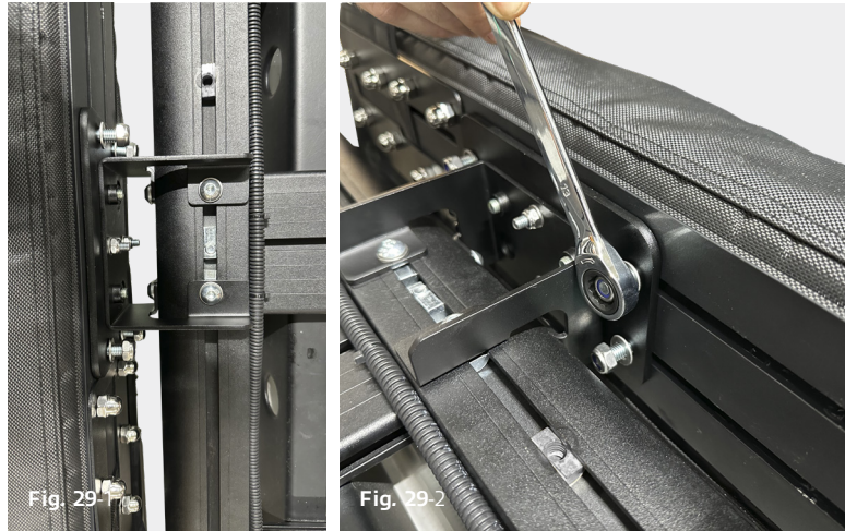
Serrage des écrous
