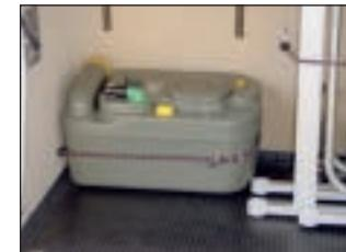
Indien u een tweede bak inzet ter vervanging, dan kunt de volle bak verschillende dagen onverlucht in de opbergplaats meevoeren. (Bij een volle bak ontstaat geen gasontwikkeling meer.)
