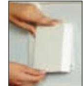
Tirez légèrement le haut du couvercle vers l'avant. Déplacez le couvercle de haut en bas et verrouillez-le en place. Insérez et serrez les vis.
