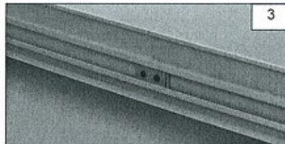
Setzen Sie die 2 Teile des Abstandprofil wieder zusammen und drehen sie Stellschrauben fest (M5).
